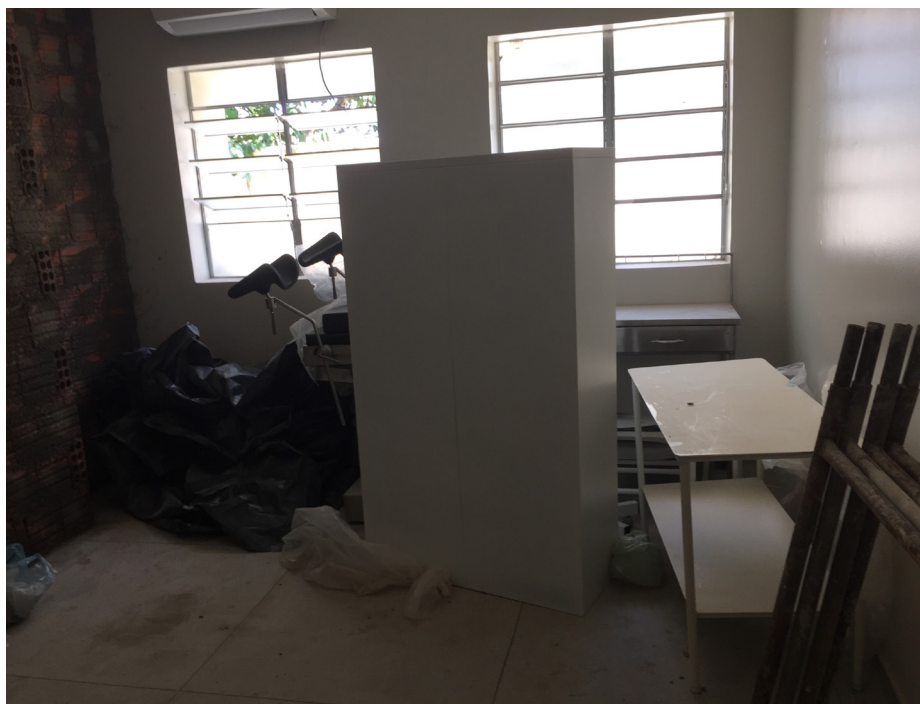
Figura 14 - Sala de parto da Apami São Miguel
